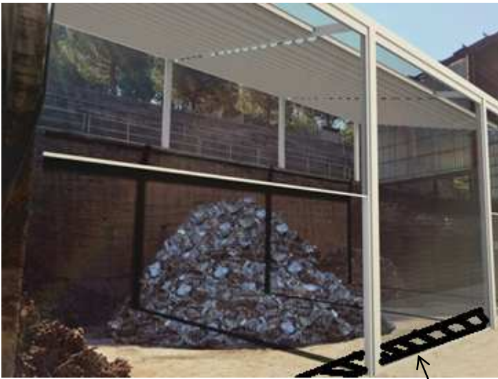
Particolare pergotenda con chiusure laterali e trincea di raccolta delle acque di dilavamento interne
